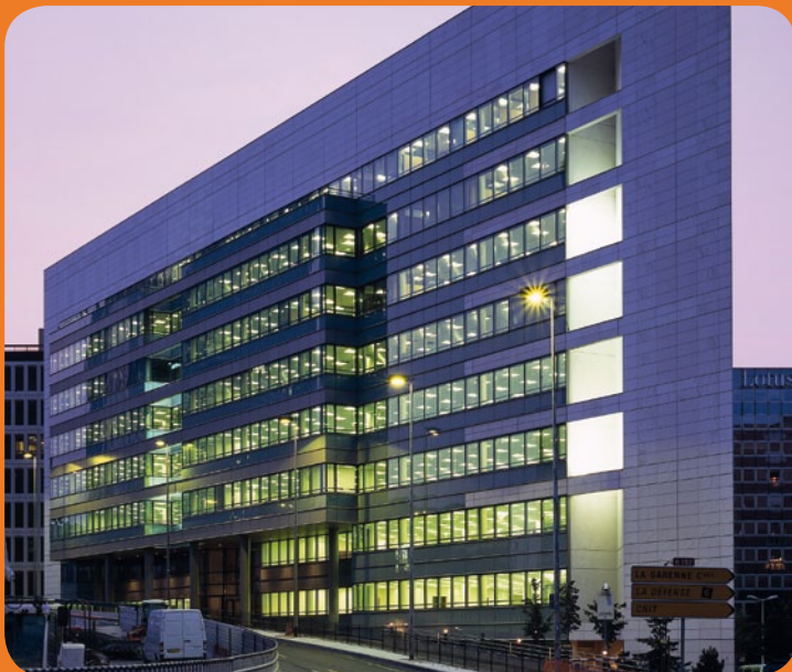
LE GYNERER BUILDING, PARIS.
