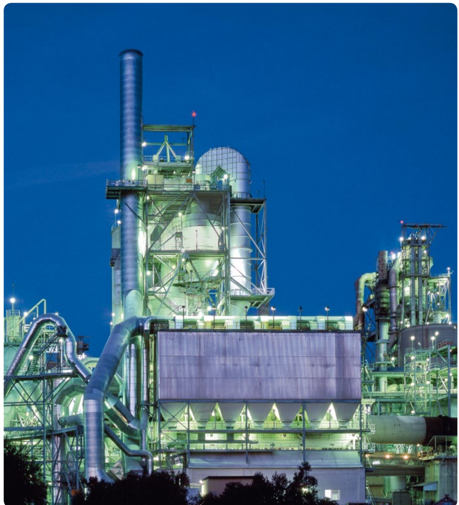
EL ALTO CEMENT FACTORY, MADRID.
