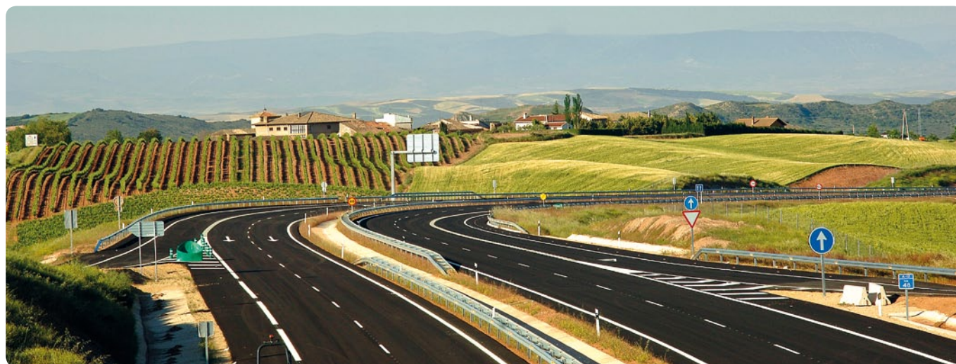
AUTOVÍA DEL CAMINO DUAL CARRIAGEWAY, NAVARRA.
