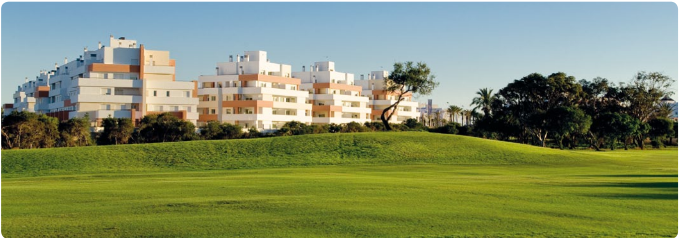
RESIDENCIAL AGUASERENA. ALMERÍA
